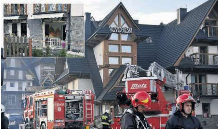
Eksplozja była bardzo silna, z budynku wyrwane zostały wszystkie okna na parterze
